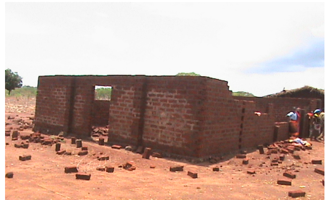
FOTO n°6 O templo em construção Zona Netia Este é o sítio aonde pensamos fazer POÇO
